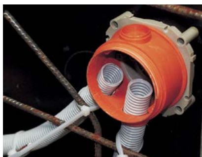
Namontované ohebné trubky do tělesa KBT.
