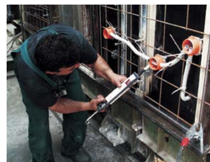
Utěsnění prostupů (tmel).
